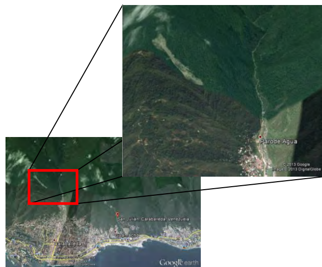
Figura 8.2. Ubicación de macrodeslizamiento de La Chara. Fuente: Elaboración propia basado en Google Earth, 2013
