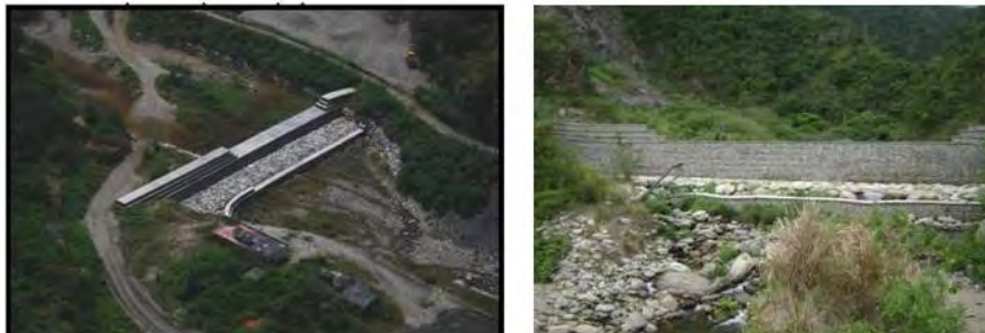
Foto 7.19 y 7.20. Presa N° 1 en el 2008 y Presa N° 2 en el 2009. Fuente: López, 2010 y Morassutti, 2010
