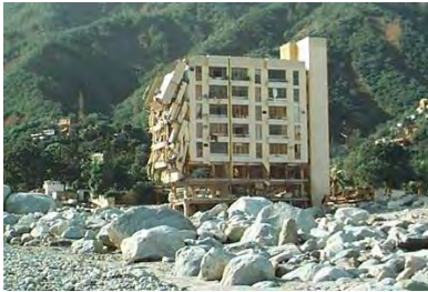
Foto 4.5. Afectación Los Corales (4) Fuente: IGVS, 2003
