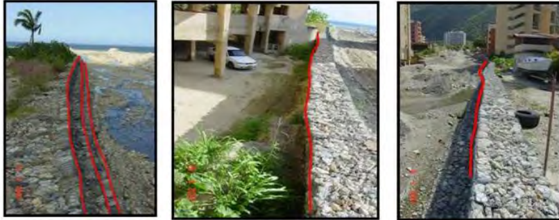
Foto 7.24, 7.25 y 7.26. Canalización de Cerro Grande en marzo de 2007. Fuente: Morassutti, 2010
