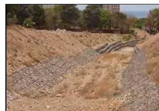
Canalización Tramo II
