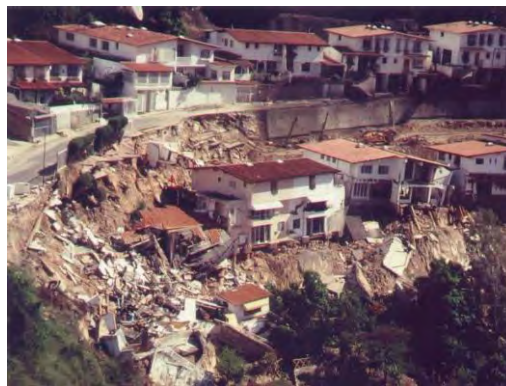
Foto 2.1. Deslizamiento en Alto Prado. Fuente: Virginia, 1993
