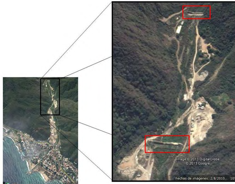
Figura 7.4. Localización de las presas de la cuenca del río Cerro Grande.
