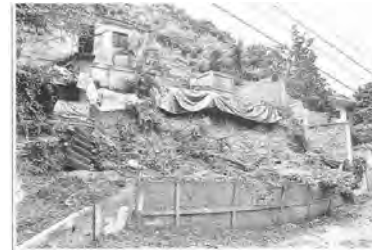
Casa afectada por deslizamiento de tierra (AV)
