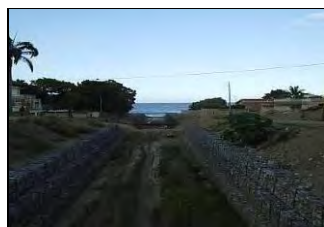
Canalización Tramo I
