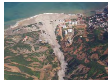
Foto 4.4. Afectación Camurí Chico Fuente: IGVS, 2003
