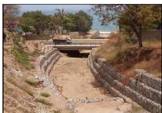
Canalización Tramo I
