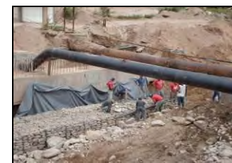
Culminación Canalización (Tramo Puente Norte)
