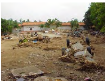
Foto 4.7. Afectación Cerro Grande. Fuente: IGVS, 2003
