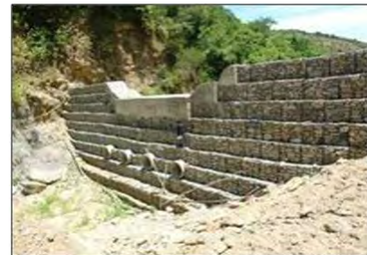
Foto 7.14. Presa Quebrada Seca. Fuente: López, 2006
