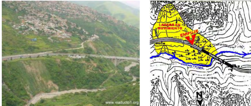
Foto 8.4. Área del macrodeslizamiento y Figura 8.1. Esquema de la masa deslizante. Fuente: FUNVISIS (2009, pág. 603) cita a Pulido (2006)
