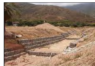
Canalización Tramo II
