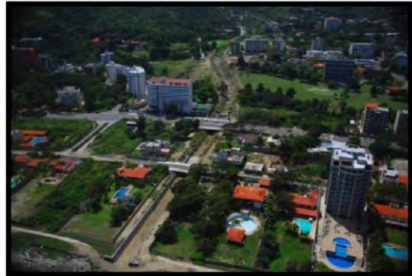
Foto 7.15. Canalización de Quebrada Seca en abril de 2007. Fuente: Morassutti (2010)
