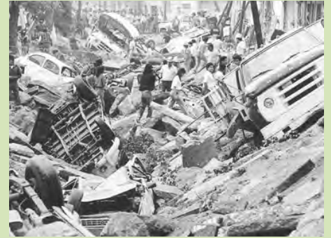
Afectación en el sector Reforma Guadalajara. Fuente: El Informador, 1992.
