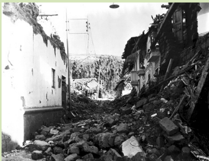
Afectación en la ciudad de Huaraz.
