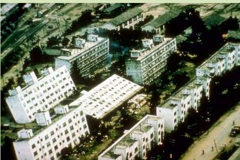
Colapso de edificaciones en Niigata en 1964.
