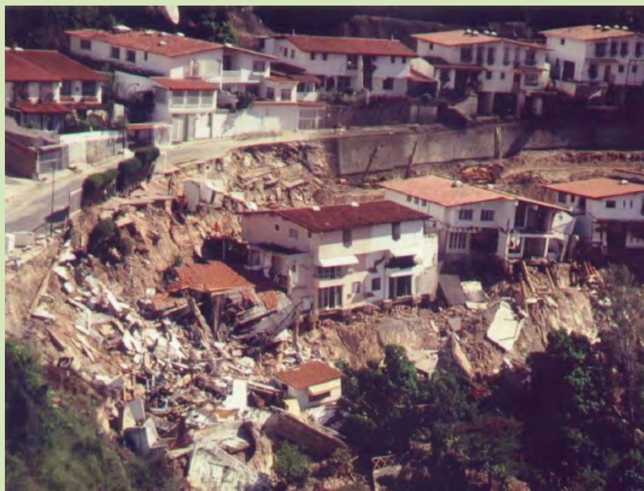
Deslizamiento en Alto Prado, Caracas. Fuente: Jiménez, 1993.
