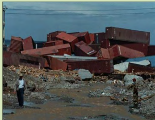
Afectación en el Puerto de La Guaira. Fuente: Proyecto Ávila, 2003.
